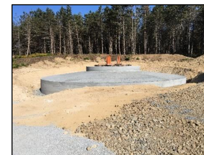
Fondation non remblayée Source : Artifex 2018
