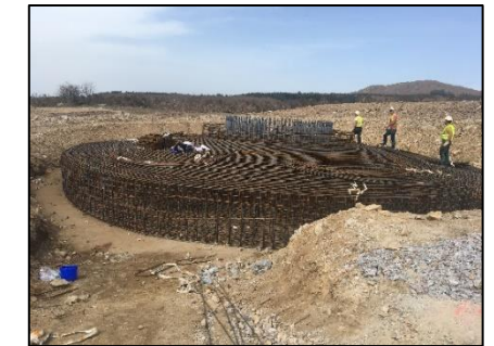
Montage de l'armature Source : Artifex 2018
