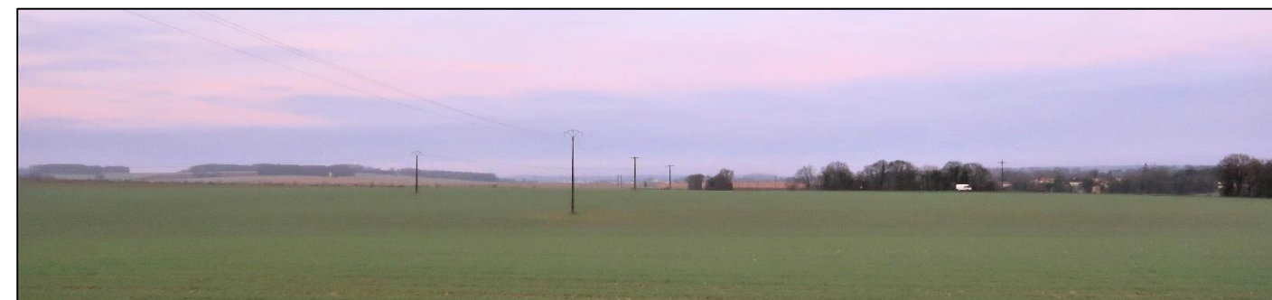
Ligne électrique dans les abords Nord de la ZIP Source : Artifex 2020
