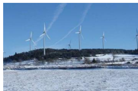
Parc de SAINT JEAN LACHALM Département : Haute-Loire (43) Puissance électrique : 18MW 9 éoliennes Mise en service : 2008
