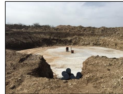
Excavation et béton de propreté Source : Artifex 2018
