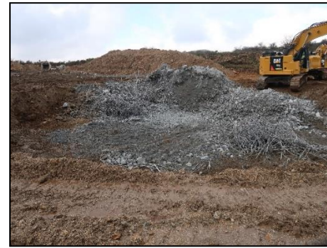
Démolition d'une fondation Source : Artifex 2018
