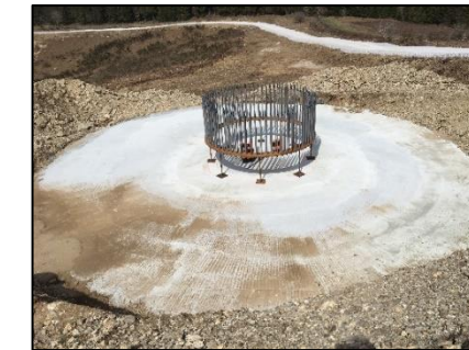
Montage de l'armature Source : Artifex 2018
