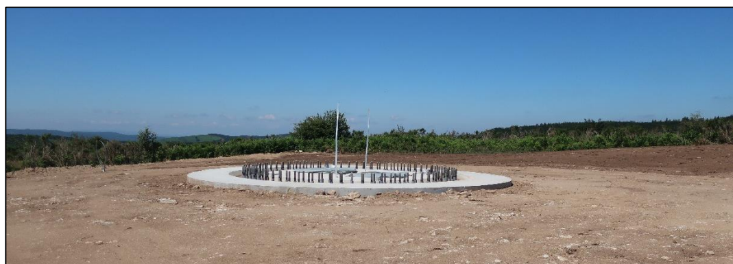
Socle remblayé Source : Artifex 2018
