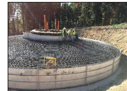
Montage de l'armature Source : Artifex 2018
