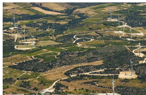
Parc éolien de FENOUILLEDES : Département : Pyrénées Orientales (66) Puissance électrique : 23,5MW 10 éoliennes Mise en service : novembre 2018
