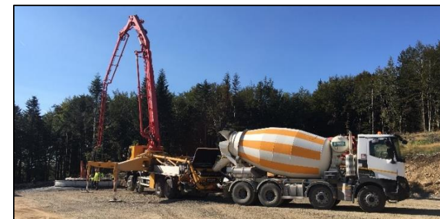
Coulage du béton Source : Artifex 2018
