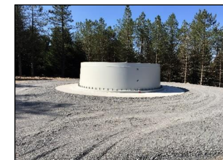
Fondation remblayée Source : Artifex 2018
